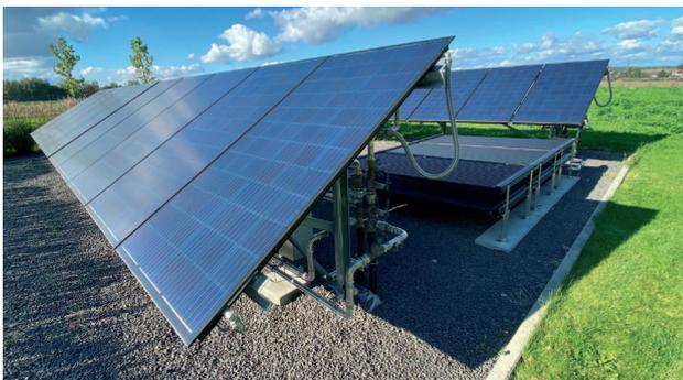
Hybrid-E-PVT-Kollektoranlage: 20 Module mit der Gesamtleistung 6,5 kW<sub>p</sub> elektrisch und 17 kW thermisch.
